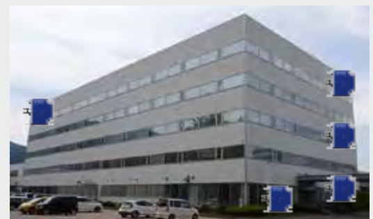
(共用棟の振動計配置)
